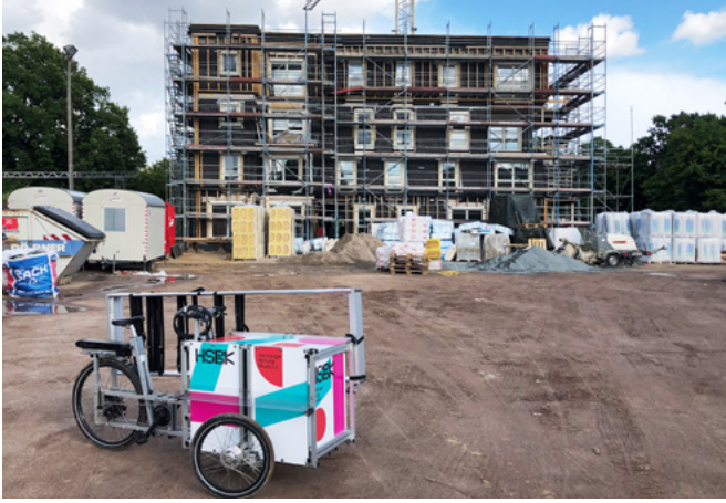
HSBK Touren #Baustelle
