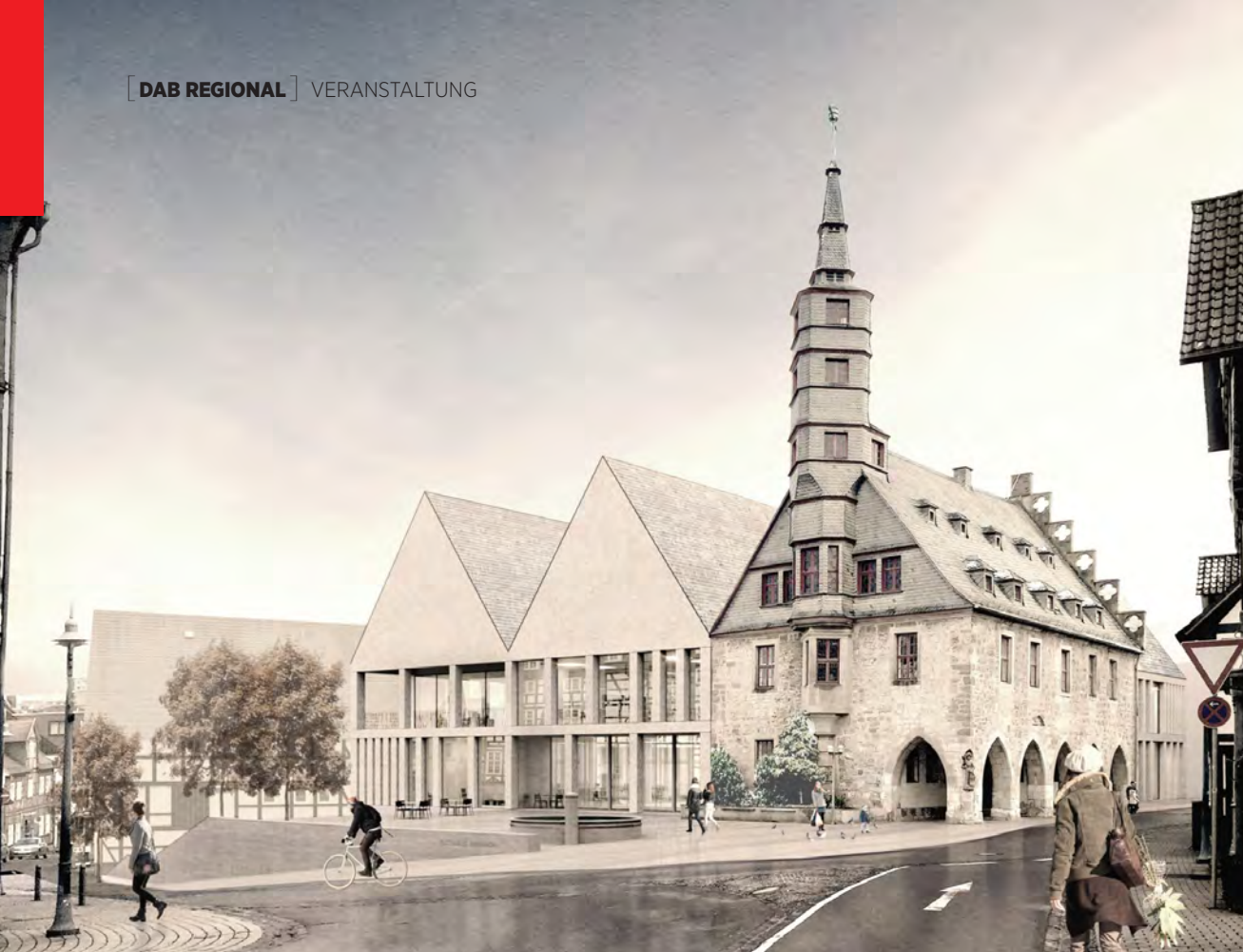
Im Sinne einer quartiersbezogenen Stadt-reparatur wird das Zentrum Korbachs mit dem mittelalterlichen Rathaus aus dem Jahr 1377 und seinem historisch geprägten Umfeld neugestaltet. Foto.: ARGE agn-heim-spielarchitekten
