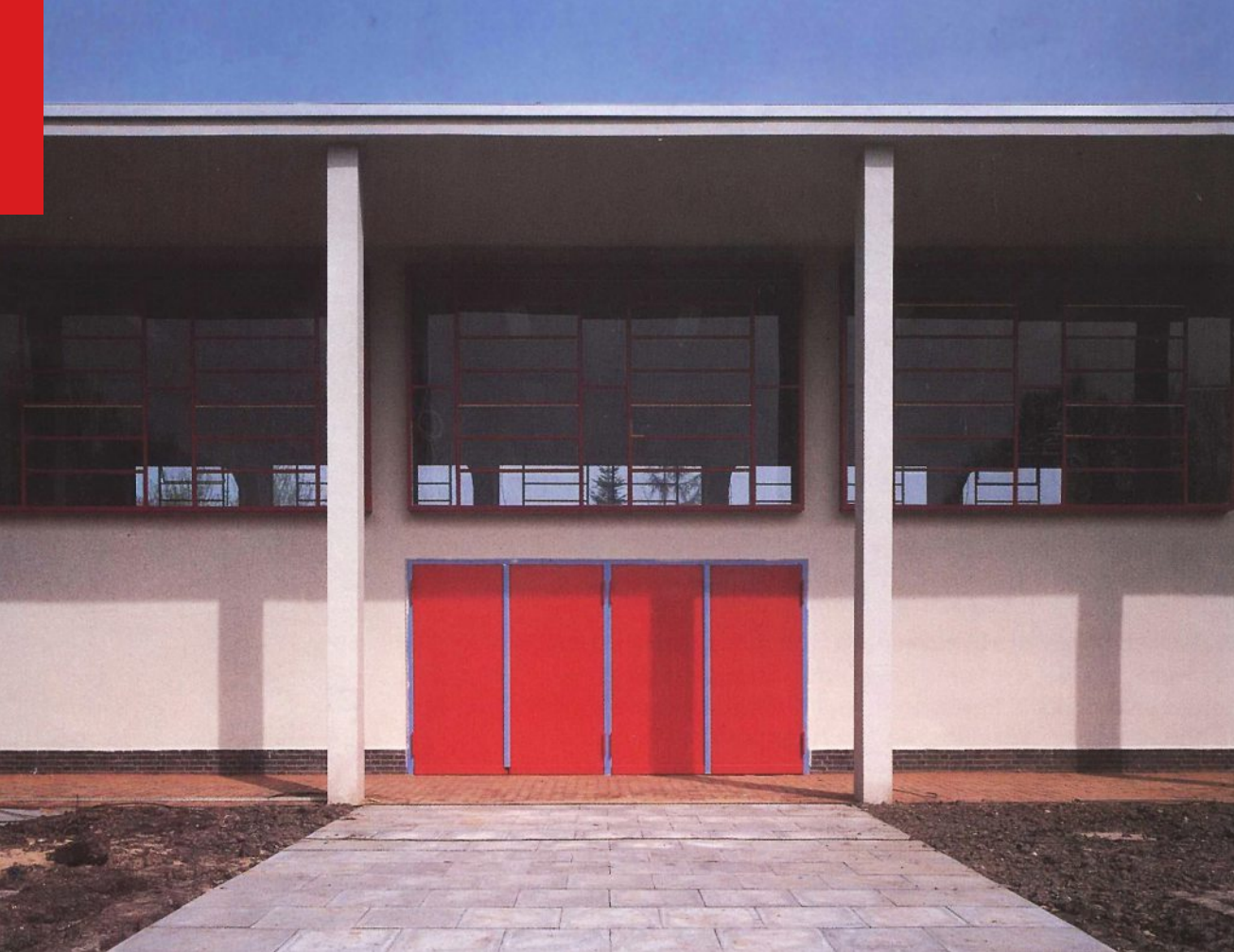
Die 1928 von Karl Schneider errichtete Turnhalle in Farmsen-Berne ist ein bedeutendes Dokument des Neuen Bauens in Hamburg. (Bild: BKM / Denkmalschutzamt)
