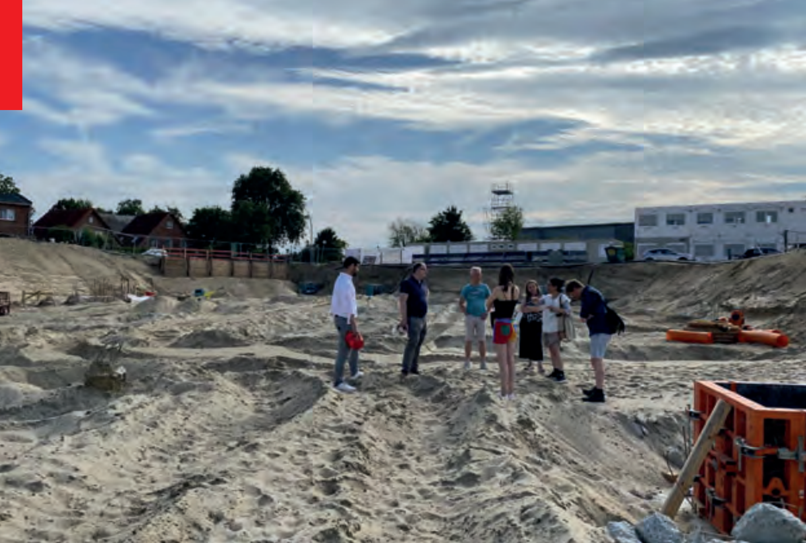
Und immer lockt die Baustelle: Georg Feldmann (WP Ingenieure) und Daniel Schmitz-Mohr (pbp architekten bda) erläutern gemeinsam die Gründung des ElbAir; Foto Malte Kurzweg, @pommesimswimmbad.
